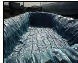
그림 8. 저압분산고무질호스(유니바이오호스) 설치 모식도 및 설치방법
