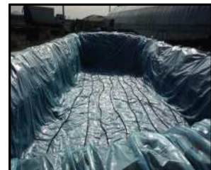
그림 8. 저압분산고무질호스(유니바이오희스) 설치 모식도 및 설치방법
